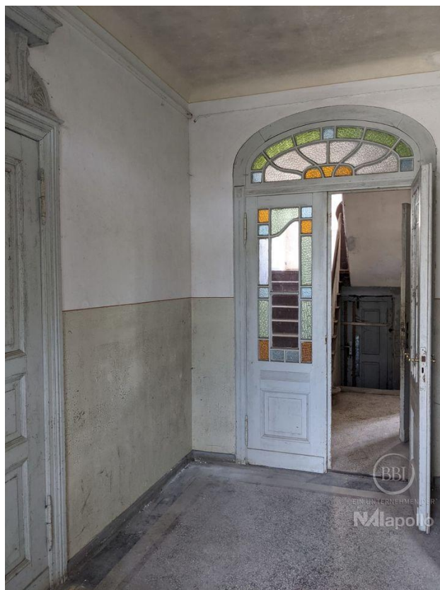
innen - vor Sanierung (5)
